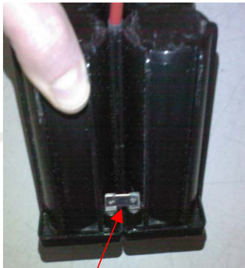
4.1 Batterie-Brücke nicht verstärkt
